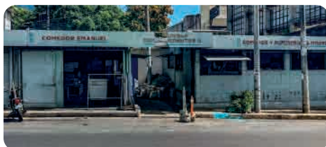
Fachada principal de acceso a la comunidad
